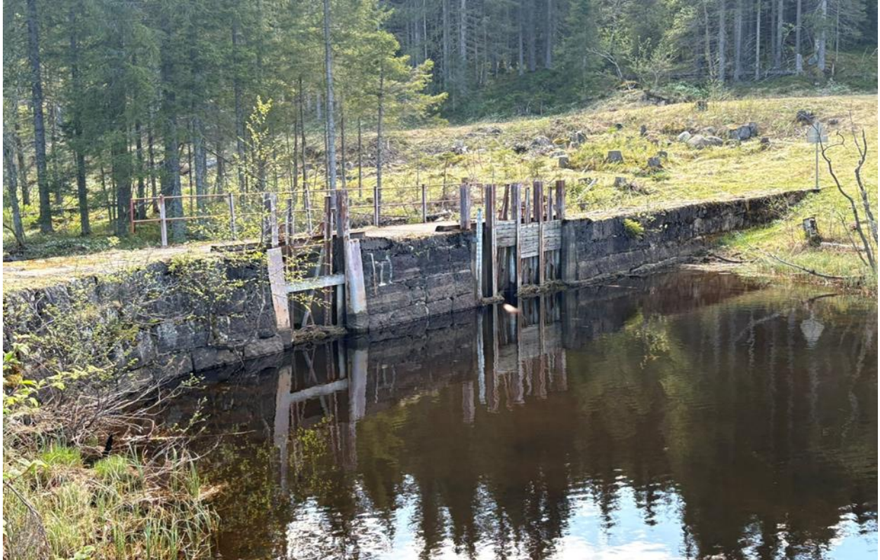
Dam sett oppstrøms. Adkomstvei i bakgrunnen. Foto: Dag Kjellevoid
