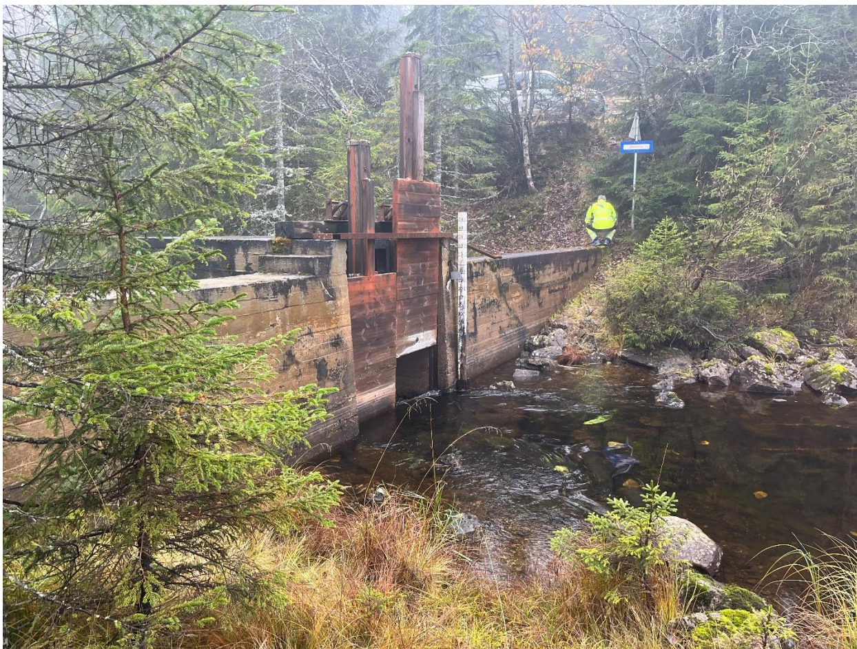
Dam sett oppstrøms. Adkomstvei med parkert bil oppe til høyre i bildet. Foto: Hafslund Produksjon
