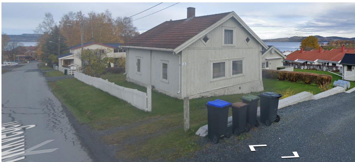
Fig 23 Arbeiderbolig i øvre del av Fabrikkvegen (Streetwiev 2019)
