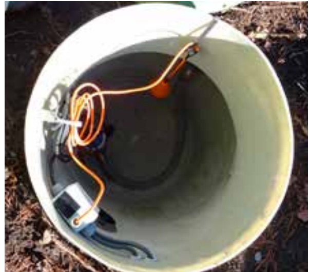
Elektriske koblinger må være tilpasset fuktighet og gasser i avløpskummer – verken stikkontakter eller koblingsbokser skal monteres i kummene
