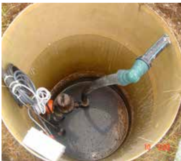
Pumpekummer med vippstyrt pumpe – pumpa har stoppet, alarm for høyt vannivå har ikke fungert/ikke vært montert, og vannnivået har steget i kummene
