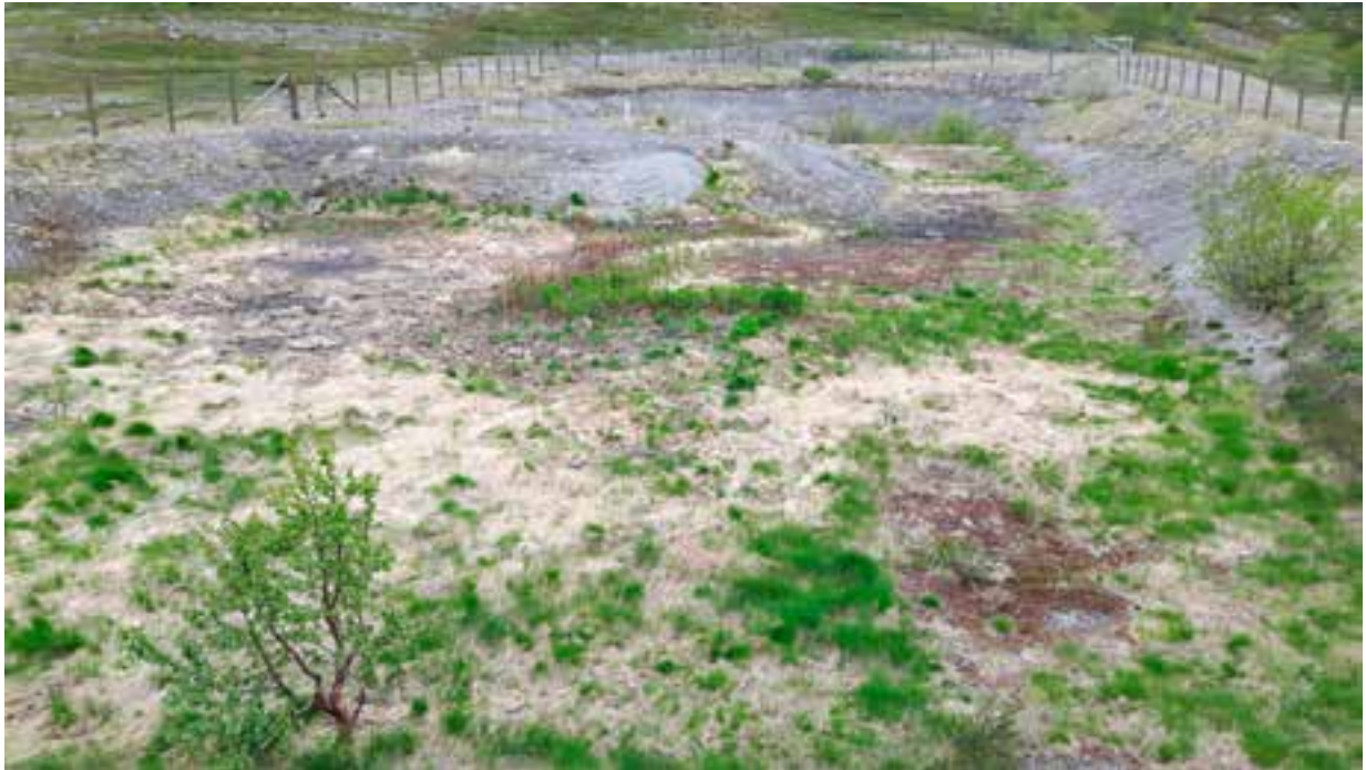
Lavt belastet åpent infiltrasjonsbasseng. Bassenget har vært i drift 15 – 20 år uten at bassengbunn er skrapet for slam.
