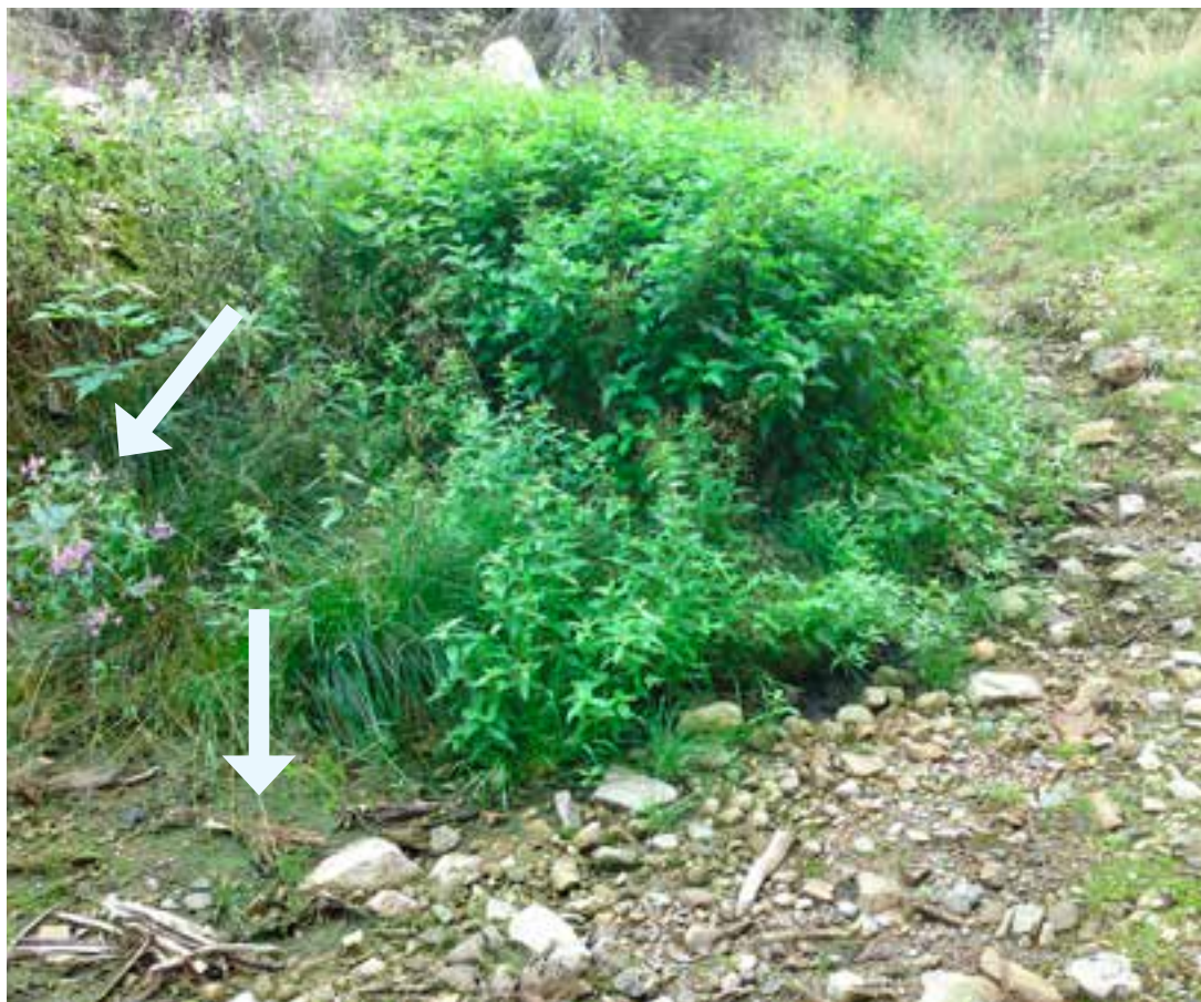
Vannutslag to meter nedenfor infiltrasjonsgrøft. Brennesle og frodig vegetasjon, samt algevekst i området.
