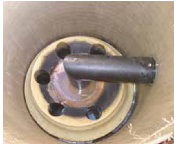
Fordelingskummer med justerbare v-overløp – flyteslam i kummene vil medføre ujevn fordeling ut i infiltrasjonsrørene og fare for gjenslemming av rør og filter
