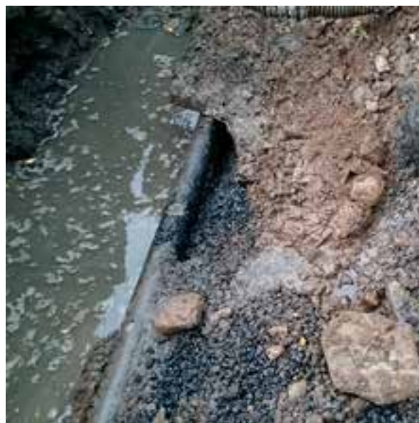
Oppgravd infiltrasjonsfilter som viser oppstuvet vann i fordelingslaget grunnet tett filterflate. Dette medfører at det blir anaerobe forhold i fordelingslaget (sort avleiring i pukken)
