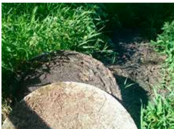
Tette infiltrasjonsgrøfter/-filtre medfører tilbakestuvning og høyt vannivå i eldre slamavskillere, slik at disse blir overfylt og avløpsvann renner direkte ut på terreng.
