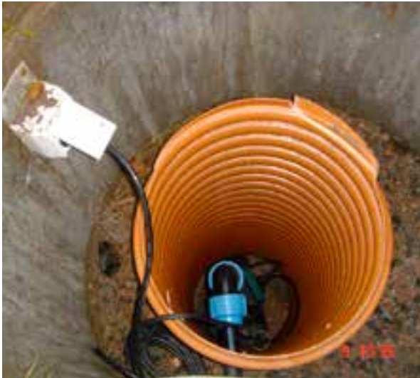
Elektriske koblinger må være tilpasset fuktighet og gasser i avløpskummer – verken stikkontakter eller koblingsbokser skal monteres i kummene
