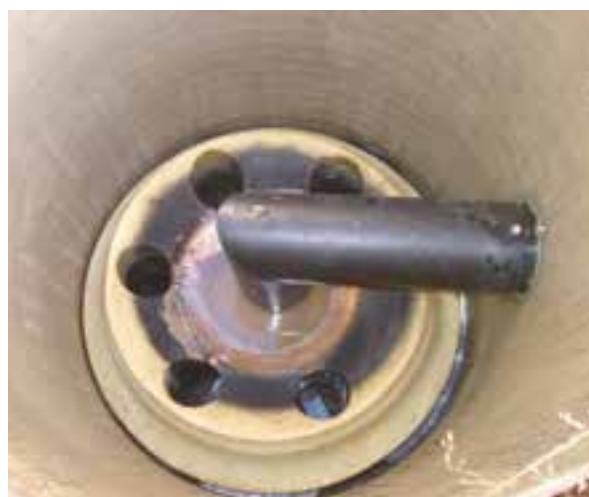
Fordelingskummer med justerbare v-overløp – flyteslam i kummene vil medføre ujevn fordeling ut i infiltrasjonsrørene og fare for gjenslemming av rør og filter
