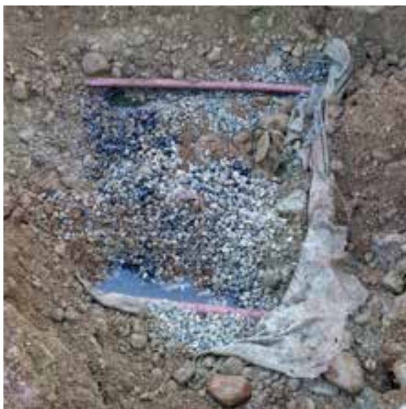
Oppgravd infiltrasjonsfilter som viser oppstuvet vann i fordelingslaget grunnet tett filterflate. Dette medfører at det blir anaerobe forhold i fordelingslaget (sort avleiring i pukken)
