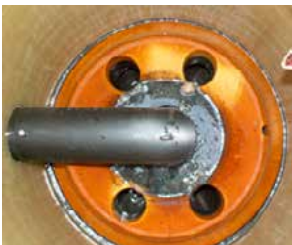
Selvjusterende fordelingskummer med flottør – rengjort og klare for bruk
