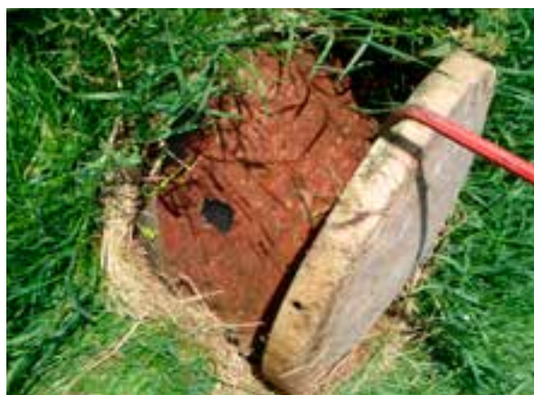
Tette infiltrasjonsgrøfter/-filtre medfører tilbakestuvning og høyt vannivå i eldre slamavskillere, slik at disse blir overfylt og avløpsvann renner direkte ut på terreng.
