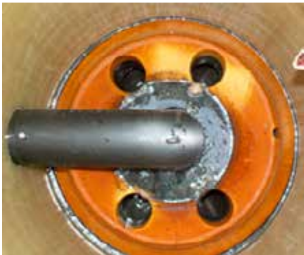
Selvjusterende fordelingskummer med flottør – rengjort og klare for bruk
