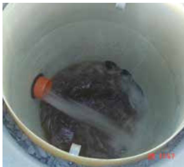
Fordelingskum med fastmonterte utløp – slamavskilt avløpsvann tilføres kummen med pumpe, slik at utløpsrørene overfylles og vannet fordeles ut i hvert av infiltrasjonsrørene ved selvfall
