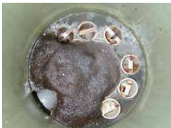
Fordelingskummer med justerbare v-overløp – flyteslam i kummene vil medføre ujevn fordeling ut i infiltrasjonsrørene og fare for gjenslemming av rør og filter
