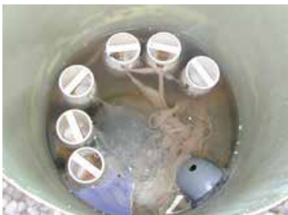
Fordelingskummer med justerbare v-overløp – flyteslam i kummene vil medføre ujevn fordeling ut i infiltrasjonsrørene og fare for gjenslemming av rør og filter
