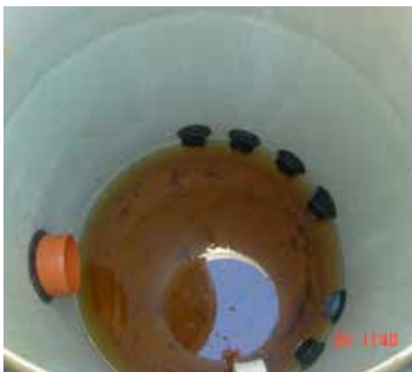
Fordelingskum med fastmonterte utløp – slamavskilt avløpsvann tilføres kummen med pumpe, slik at utløpsrørene overfylles og vannet fordeles ut i hvert av infiltrasjonsrørene ved selvfall
