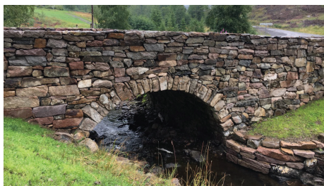
Skjærenbrua ble ferdig restaurert i 2017
