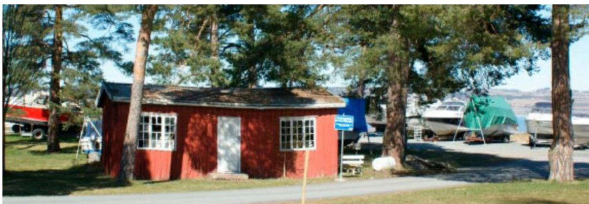
Fig 63 Bildet viser det tidligere billettkontoret
