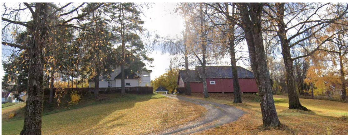
Fig 21 Kontorsjef Hjerkinns sin bolig, Kveldsro, sett fra Kveldsrovegen (Streetwiev 2019)
