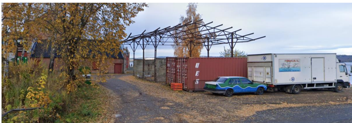
Fig 65 Bildet viser o_PA3 med kullbingen – sett fra øst mot Kapp melkefabrikk
