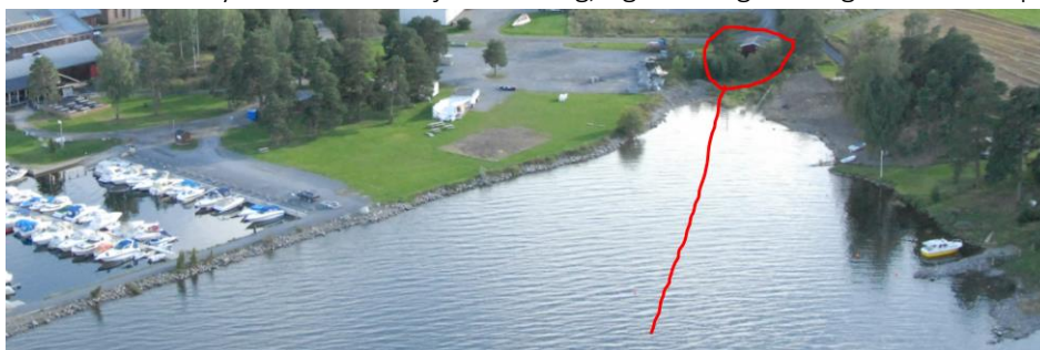
Fig 11 Pumpehus og inntaksledning for Hoff vatningsanlegg.
