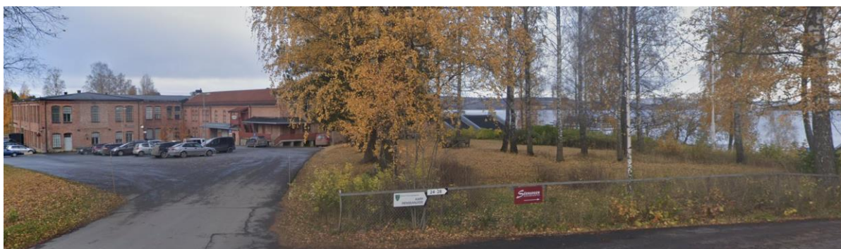
Fig. 66 Bildet viser o_PA3 sett fra Fabrikkvegen
