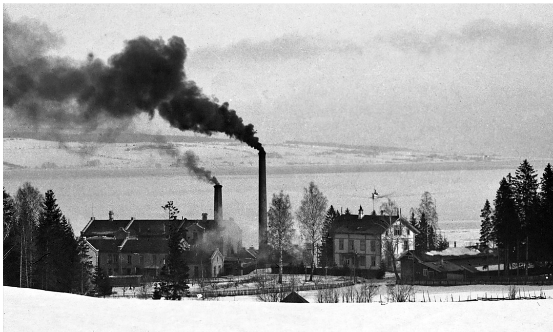
Kapp melkefabrikk ca. 1915 med røyk fra begge pipene.
