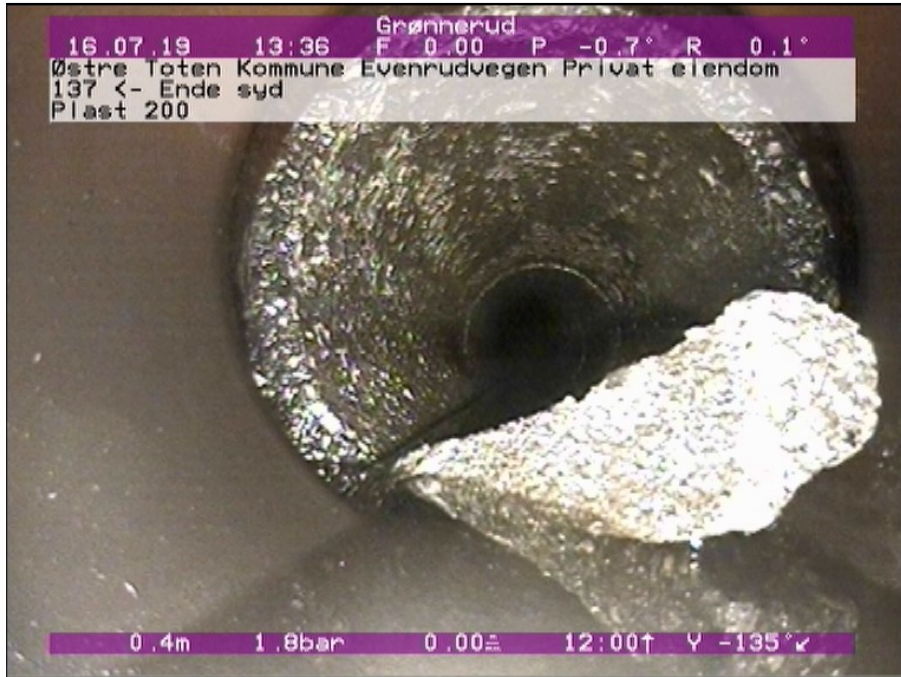
Foto: 9_1_2_16072019_133117_A.JPG 0,41m, Materialending til Betong
