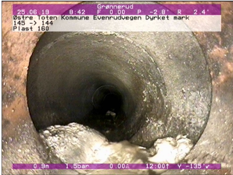
Foto: 2_1_2_25062019_083642_A.JPG 0,9m, Materialendring til Betong
