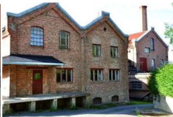
Fig. 9 Fabrikkens fasade mot øst
